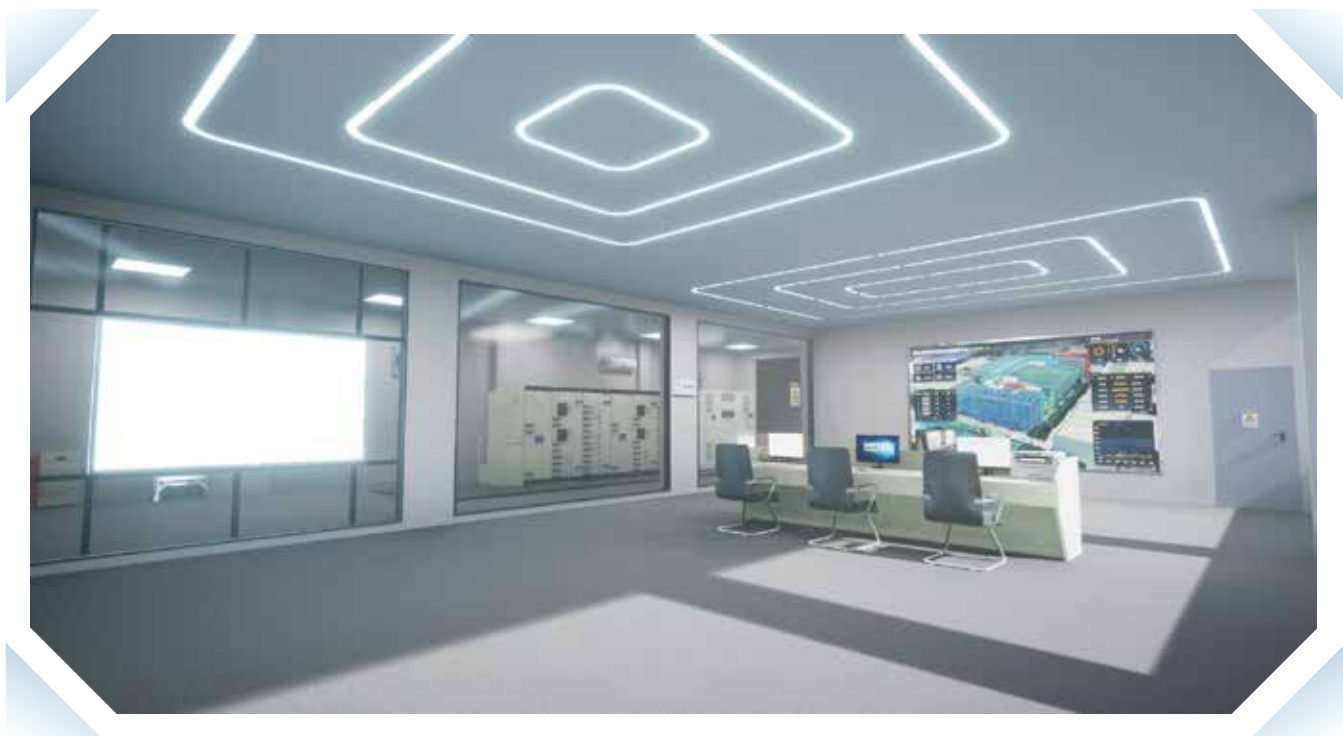
智慧集中监控运维中心
